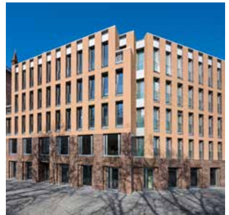
Gebäudeansicht Bertelsmann Stiftung Berlin | © Ulf Büschleb
